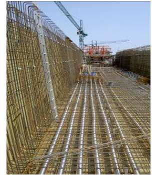
Herstellung einer Brückenbodenplatte mit Spannbeton (aus Wikipedia)
