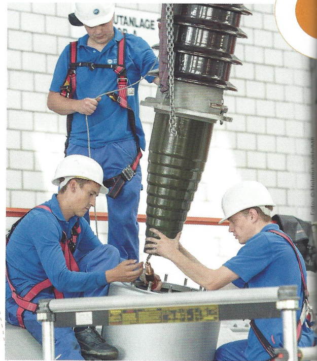
Einbau von Durchführungen an einem Regeltransformator
