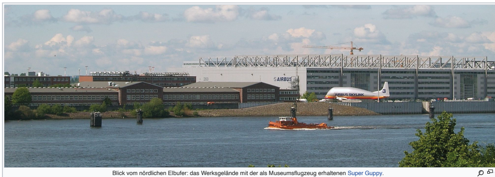
Blick vom nördlichen Elbufer: das Werksgelände mit der als Museumsflugzeug erhaltenen Super Guppy.
