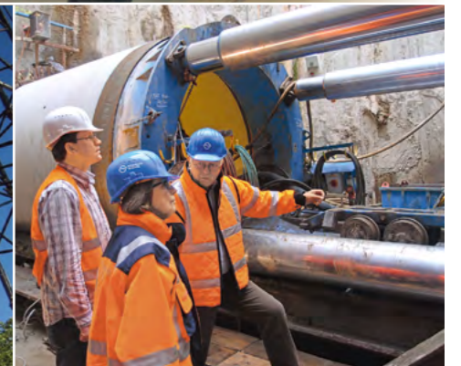
Oben: Vor ihrer Inbetriebnahme muss die Bauausführung der neuen Siele sorgfältig geprüft werden. Unten links: Die Rohre liegen auf der Baustelle abschnittsweise für den Vortrieb bereit. Unten rechts: Hydraulikstempel drücken das neue Kanalrohr ins Erdreich.
