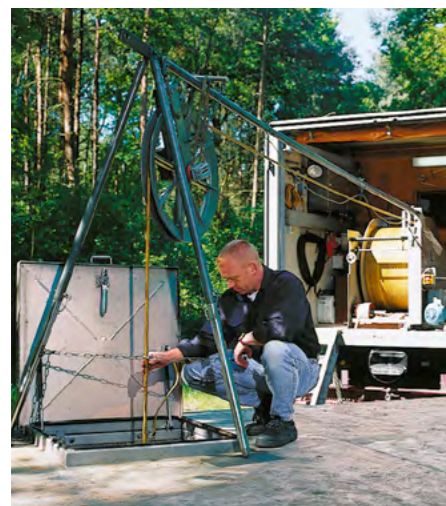
Zur Überprüfung eines Vertikalfilterbrunnens wird eine Videokamera in den Brunnenschacht eingefahren.
