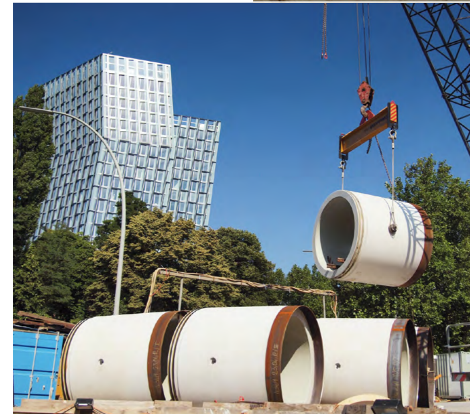
Oben: Vor ihrer Inbetriebnahme muss die Bauausführung der neuen Siele sorgfältig geprüft werden. Unten links: Die Rohre liegen auf der Baustelle abschnittsweise für den Vortrieb bereit. Unten rechts: Hydraulikstempel drücken das neue Kanalrohr ins Erdreich.
