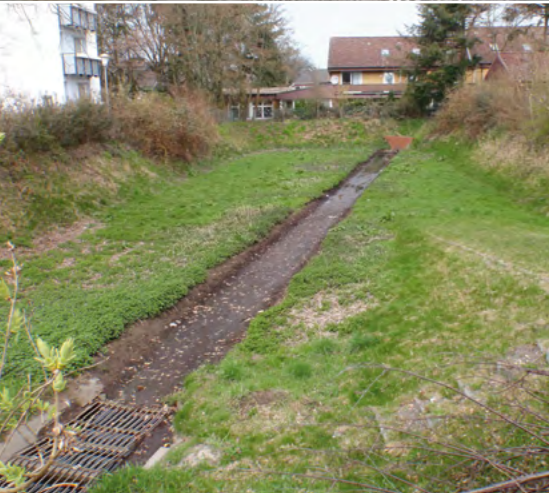
Oben: Starkregenereignis 2011: Überschwemmung des Innenhofes im Gebäudekomplex Zippelhaus. Rechts: Regenrückhaltebecken Haferacker im Stadtteil Hausbruch.
