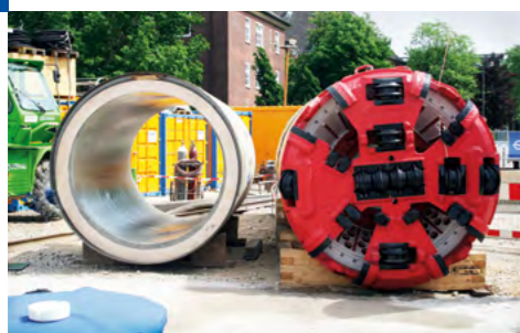
Oben links: Der Bohrkopf fräst altes Sielmauerwerk fort, um Platz für ein neues Rohr zu schaffen. Oben rechts: Die Vortriebsmaschine wird in den Bauschacht hinabgelassen, um dann auf Höhe des neu zu erstellenden Siels eingerichtet zu werden. Unten links: Ein Bohrschild neben dem einzubauenden Rohrstück. Unten rechts: Die gesamte Vortriebsapparatur mit Hydraulikanlage und Technik zur Ausspülung des Abraums.
