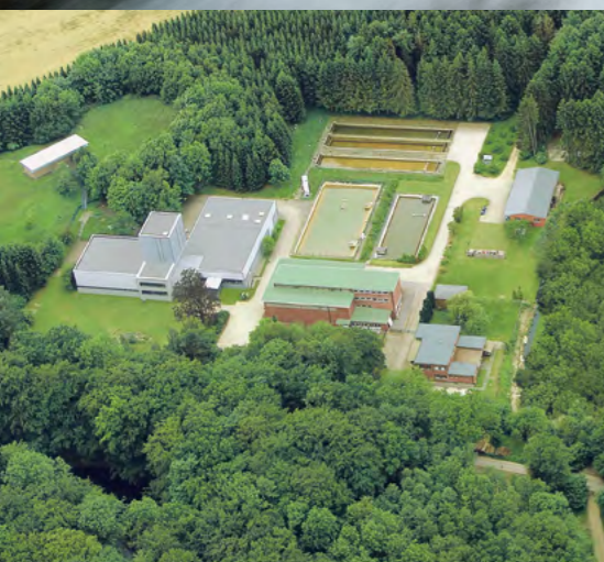
Oben: Offene Belüftung des Wassers im Wasserwerk Walddörfer. Unten: Das Wasserwerk Großhansdorf aus der Vogelperspektive.
