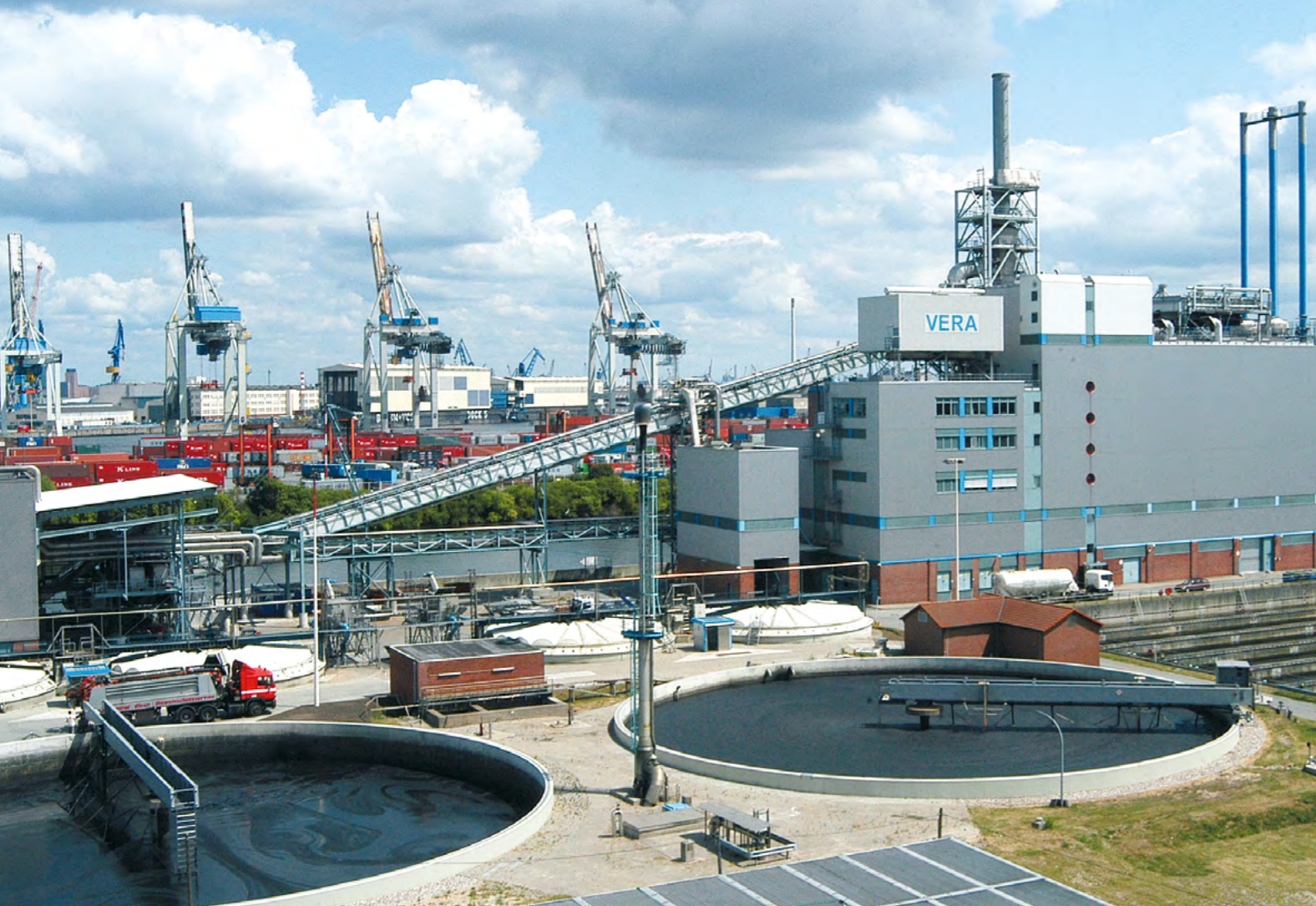
Die VERA – ein eigenständiger Betriebsteil zur thermischen Verwertung des Klärschlammes. Im Vordergrund: zwei Becken zur Behandlung des Faulschlammes.
