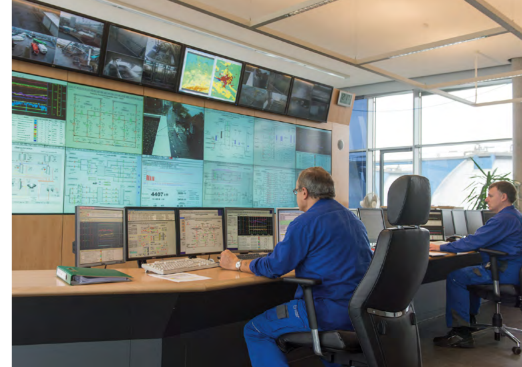
Oben: In der zentralen Leitwarte wird der Reinigungs- und Schlammbehandlungsprozess überwacht und gesteuert. Mitte: Kontrolle des Klärprozesses im Labor. Unten: Becken zur biologischen Abwasserbehandlung.
