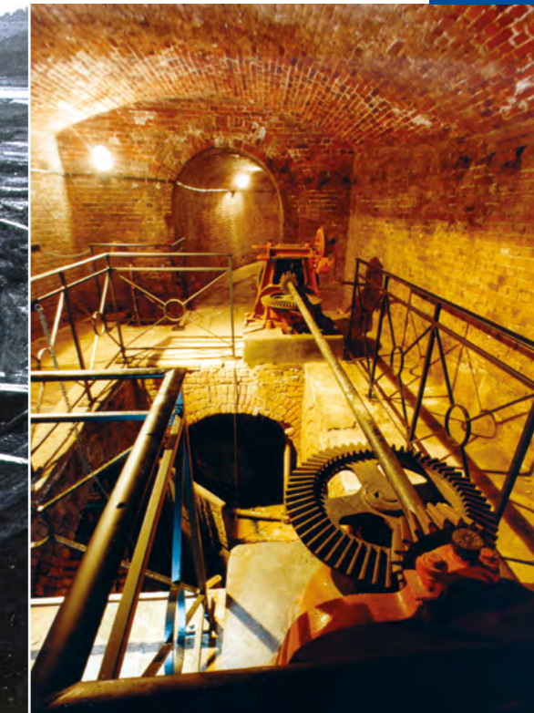
Links: Bau des Pumpwerks Anckelmannsplatz 1879, das noch heute ein Kernstück des Hamburger Abwassernetzes ist. Rechts: Zugang zum alten Düker unter der Lombardsbrücke, der bis 1995 genutzt wurde.
