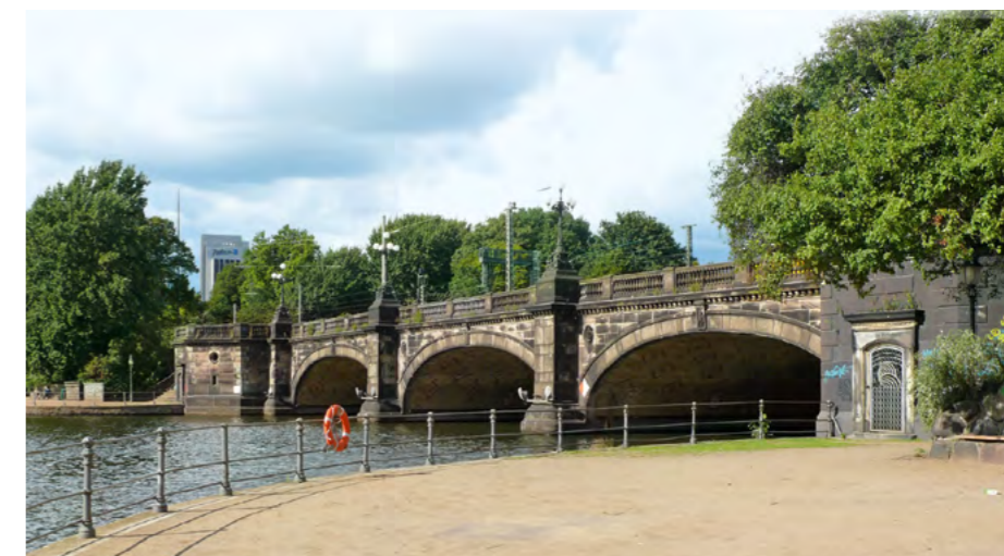
Unter der Lombardsbrücke verbanden sich der östliche und westliche Teil des Geeststammsiels.
