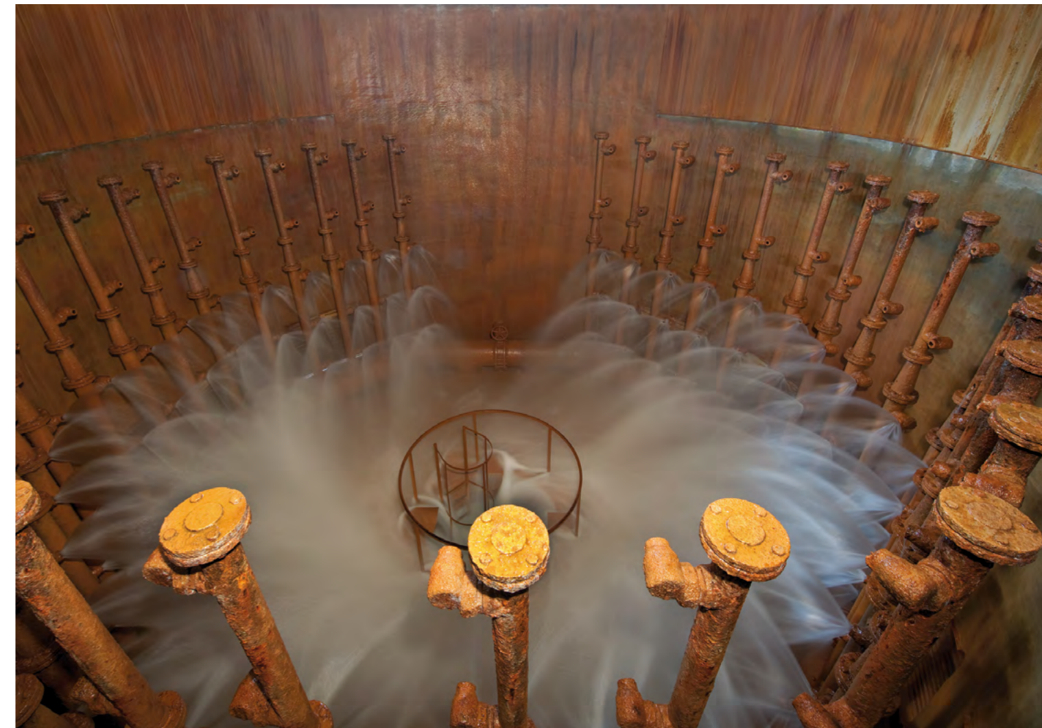
Belüftungskammer im WW Glinde: Durch den Kontakt mit der Luft entweichen Schwefelwasserstoff und überflüssige Kohlensäure.
