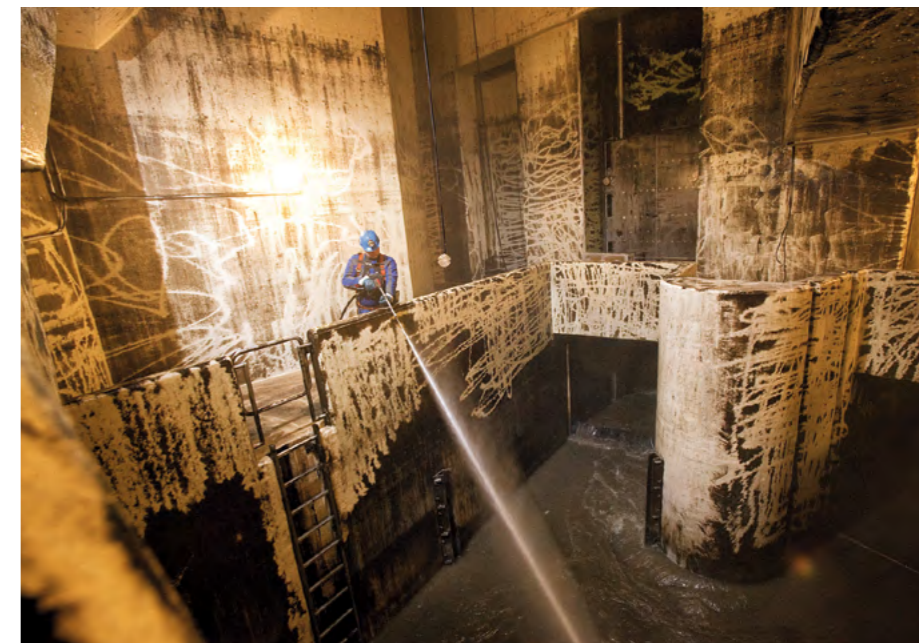
Oben: Die Elbe ist heute auf bestem Wege der Genesung. Mitte: Ein Mischwasserspeicher wird gereinigt; der Sammler Flottbek. Unten: Auch die kontinuierliche Kontrolle gehört zu den Wartungsarbeiten, die den Sammler funktionsfähig halten.
